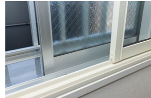
全住戸の内窓設置を実施
