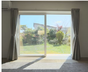
外窓交換(はつり工法)を実施
